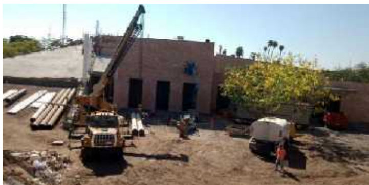
Obreros trabajando en la obra.
